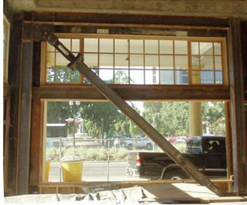
Figura 2.15: Instalación de un disipador viscoelástico
