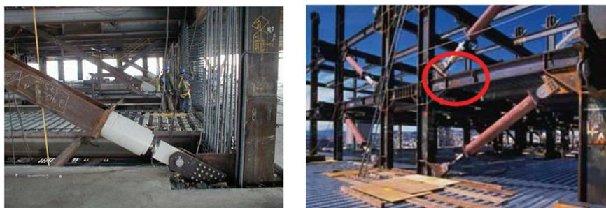
Figura 2.10: Ejemplos de disipadores de fluido viscoso
