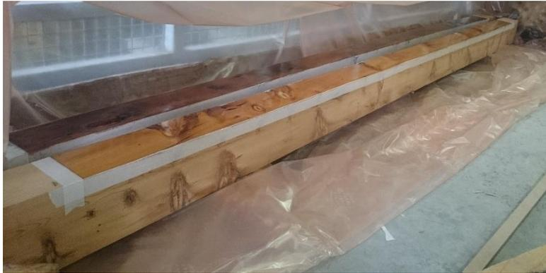
Figura 21. Imprimación aplicada sobre la viga.
