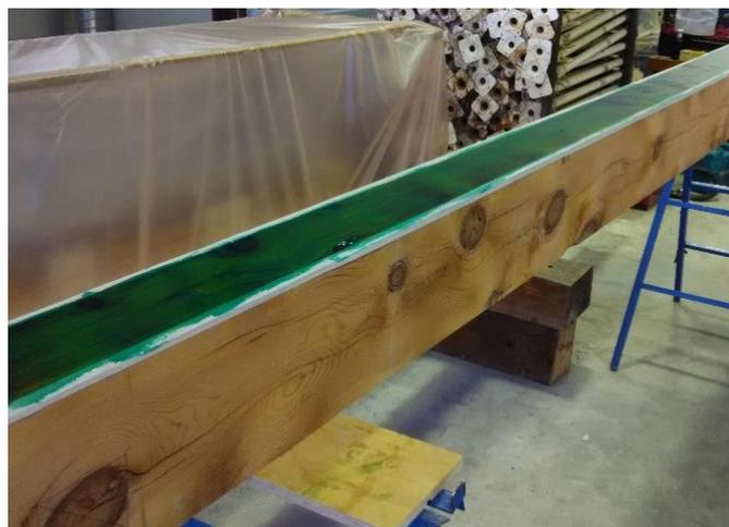
Figura 22. Aplicación de la resina sobre la viga.
