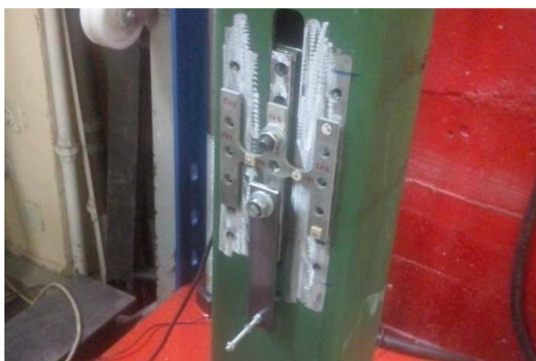
Figura 4.3. Fijación de la placa sobre la cara del sistema “tubo en tubo”.
