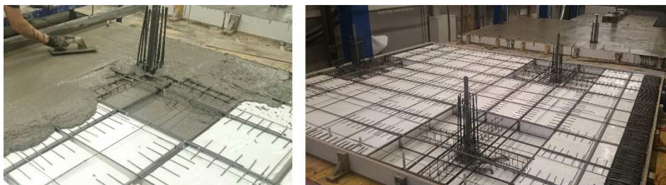
Figura 6.14. Hormigonado del forjado del espécimen. Izq.: Vertido del hormigón. Der.: Estado previo y posterior al vertido del hormigón.
