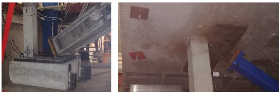
Figura 4.25. Anclaje de disipadores a la estructura. Izq.: Disipador C1 anclado a la base de P1. Der.: Disipador C3 anclado al ábaco de P2.
