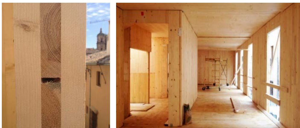
Figura 4. Edificio de 4 plantas construido con CLT en el centro de Granada (Bonsai Arquitectos).
